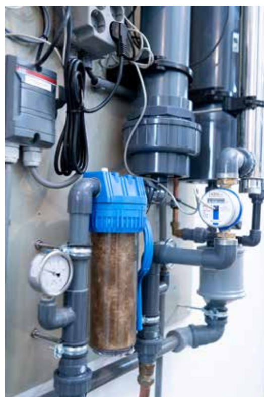
Het microfilter in het SafeWater-systeem haalt de kleine delen uit het water, waarna het water wordt gezuiverd door een actief koolfilter, UF-membraan en een UV-lamp.
